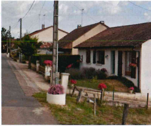
Figure 10 - Vue des avants aménagés route d'Houéville.
