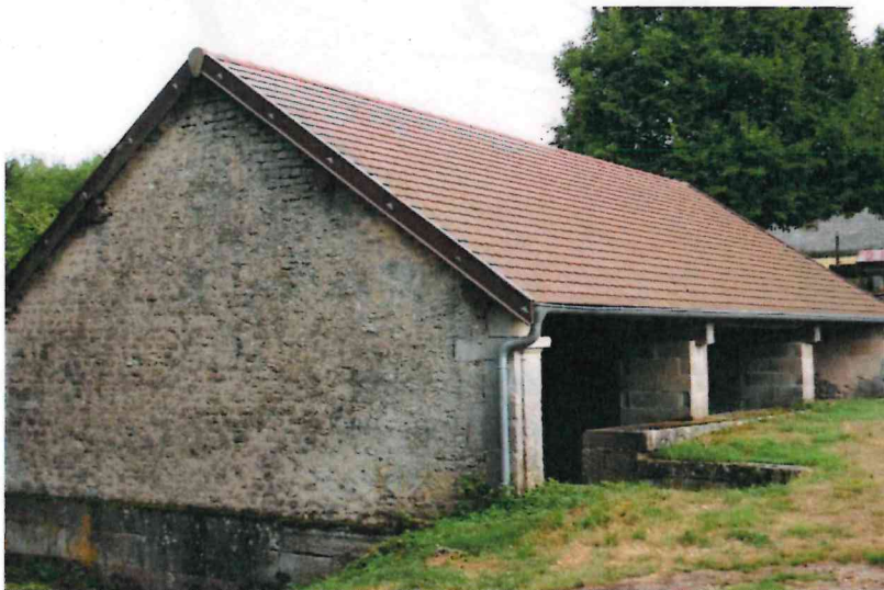
Figure 13 - Lavoir du seugnon.
