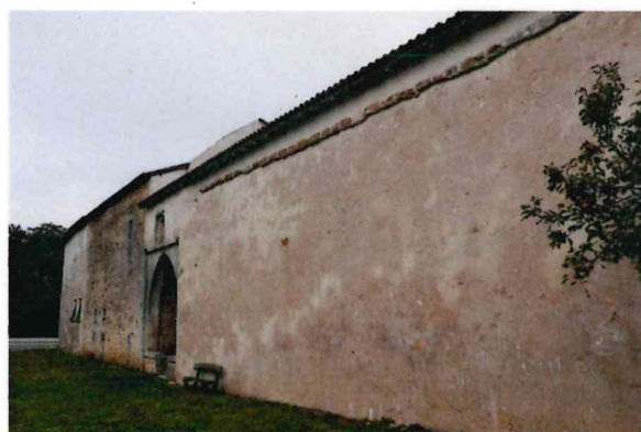
Figure 7 - Façade sud du château.
