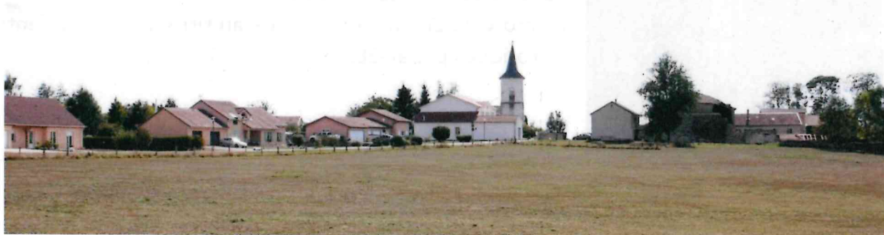
Figure 10 - Vue d'ensemble des 3 MH depuis le plateau au Nord du village.
