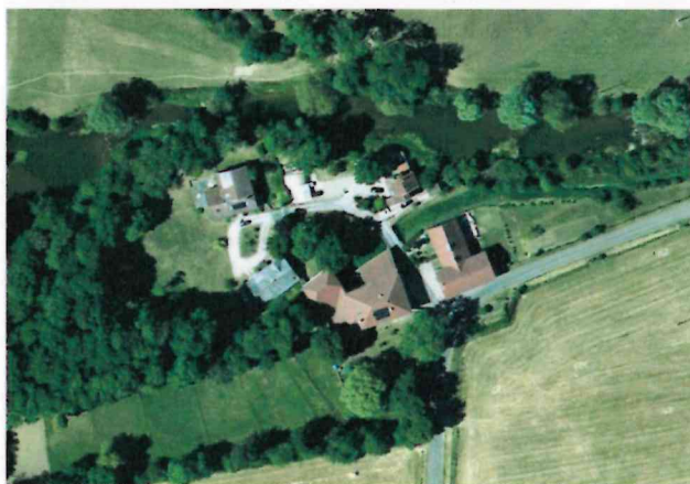
Figure 7 - vue aérienne du site de la forge
