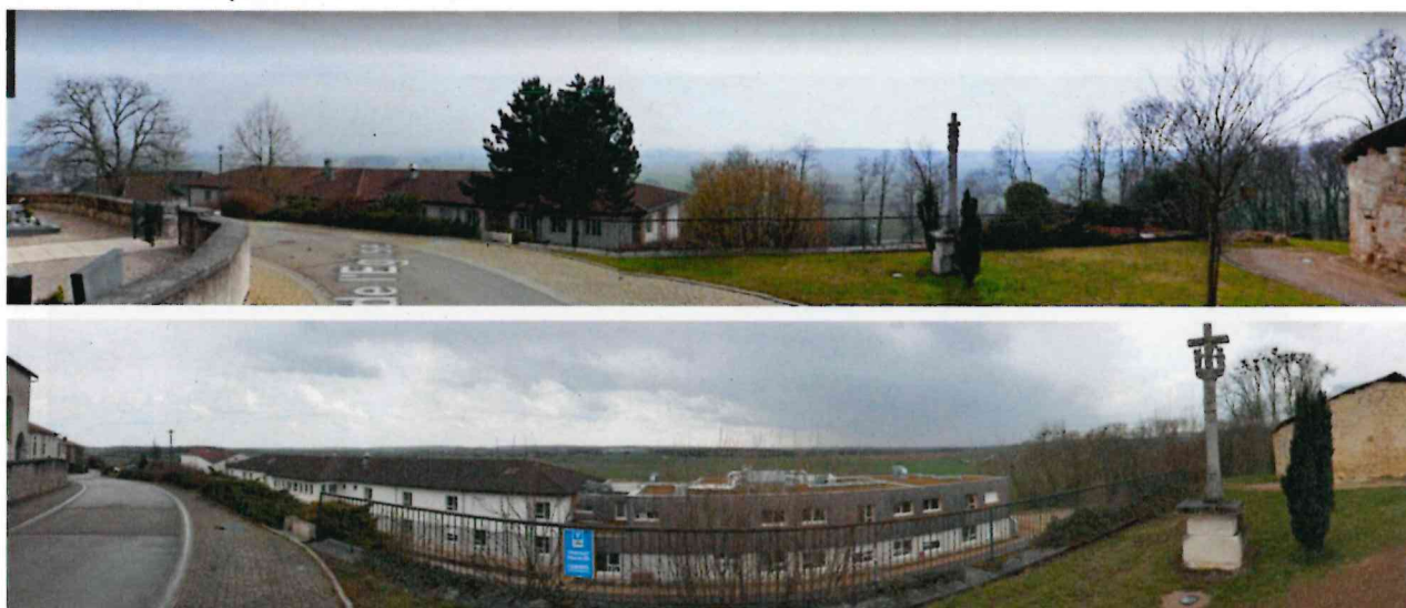
Figure 21 - Vue d'avant et après l'extension de la maison de retraite.
