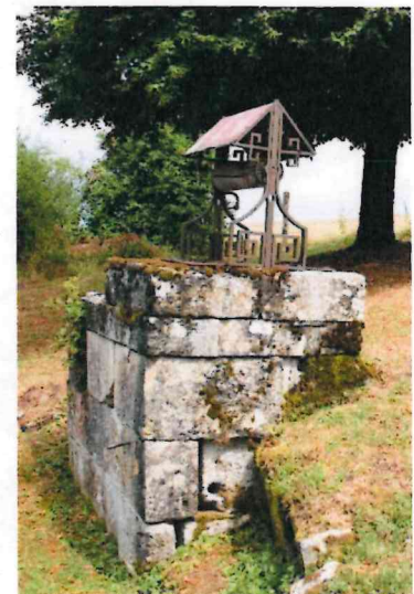
Figure 14 - Puit du lavoir du seugnon.
