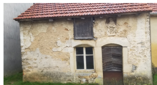
6. ÉLÉMENTS ARCHITECTURAUX DES FACADES
