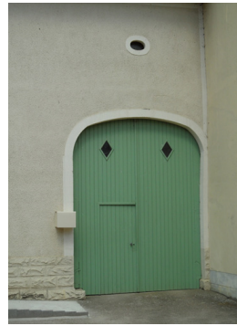
40. ARRONDI DE PORTE DE GRANGE AVEC PIERRES APPARENTES DES OUVERTURES ; CŒIL DE BŒUF
