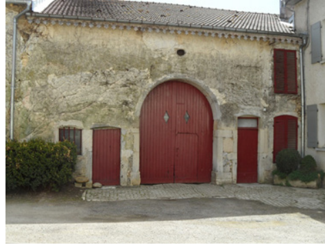
39. ARRONDI DE PORTE DE GRANGE, DE PORTE DE SERVICE ET FENÊTRE AVEC PIERRES APPARENTES DES OUVERTURES ; CŒIL DE BŒUF
