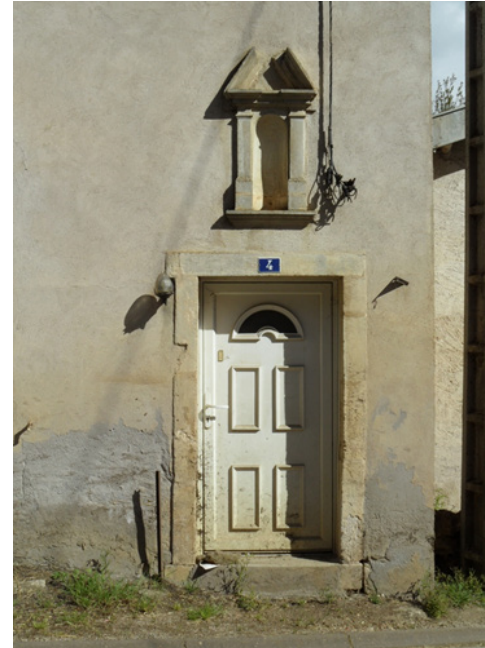
3. NICHE ARCHITECTURALE AU-DESSUS DE LA PORTE D'ENTRÉE ET PIERRES APPARENTES DES OUVERTURES
