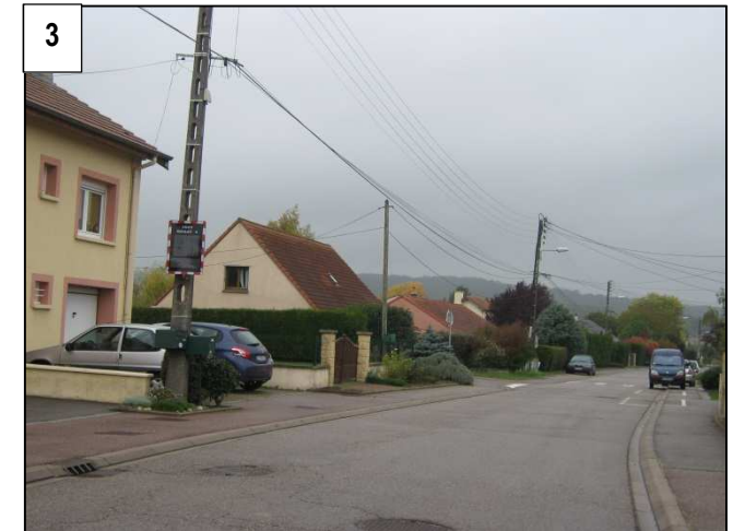
3 Rue Jeanne d'Arc, trottoirs des deux côtés de la voirie avec un stationnement « à cheval » sur la route et le trottoir.
