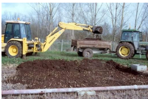
← Opération de curage d'un filtre planté de roseaux
