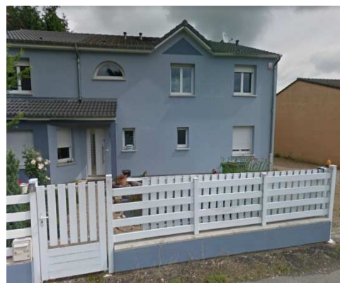
Clôture à claire-voie
