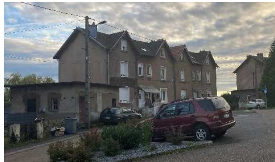
Rue de Fechains – Cités-Doncourt
