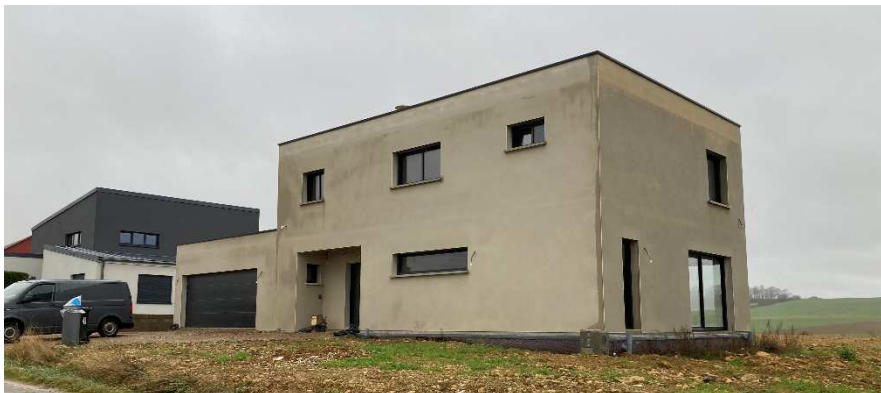
v Extension récente au coup par coup rue des Moissonneurs – Source : Skape, 2021
