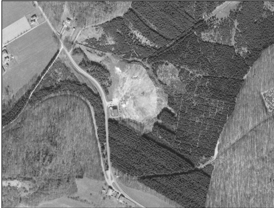
Construction du 1 er bâtiment
