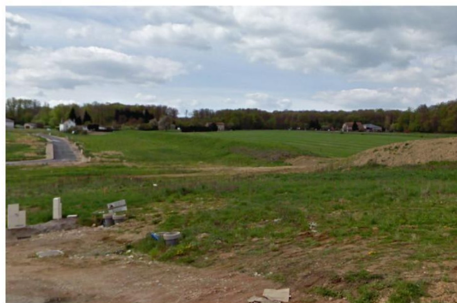
2_ Le talus et le futur chemin piéton en phase de réalisation
