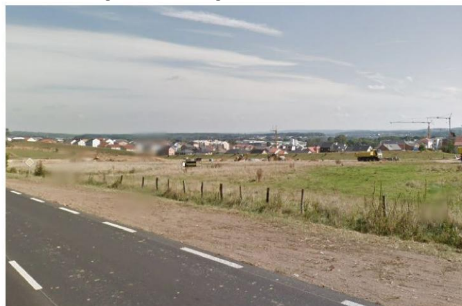
2_ Les travaux de viabilisation en septembre 2012
