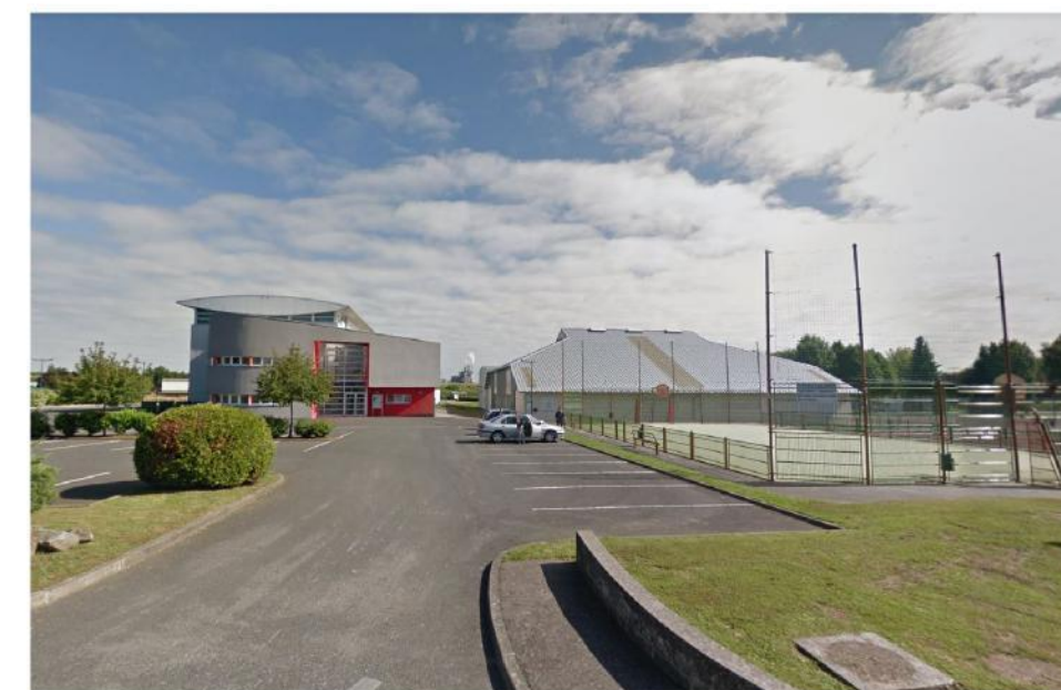
3_ Le centre Lepage et le bâtiment des tennis couverts
