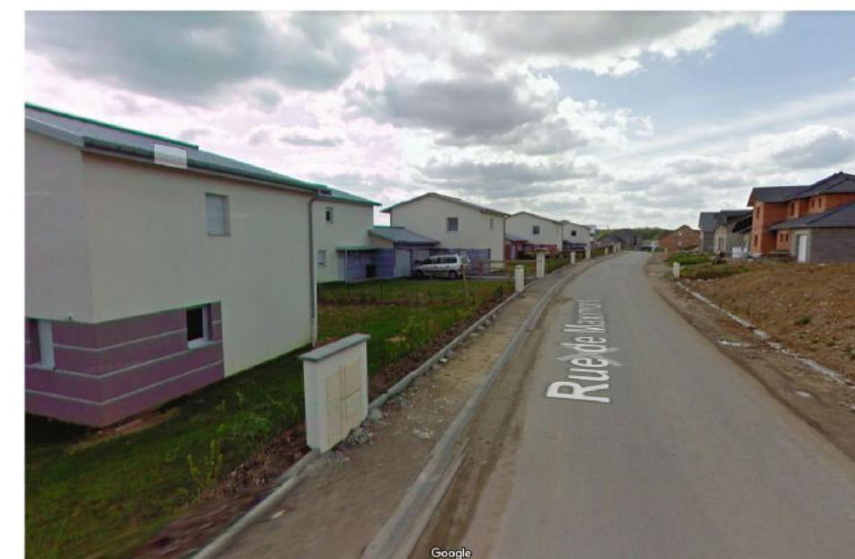
3_ Le lotissement des Hauts Cailloux
