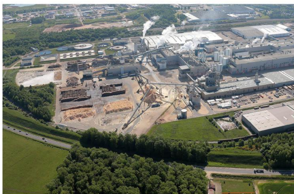
2_ Dispositif de protection en bordure du site
