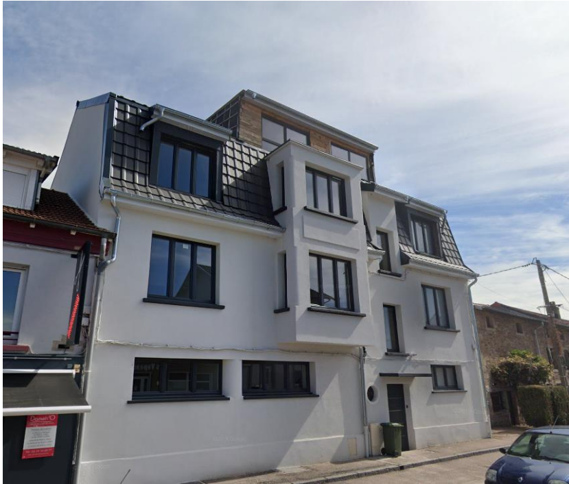
Immeuble rue de Lorraine, considéré comme vacant par LOVAC, réhabilité pour la vente de 4 logements
