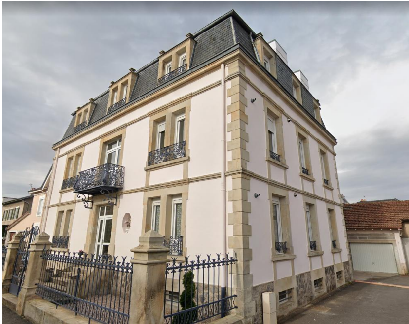
Immeuble rue de Beaulieu, classé comme vacant, mais logements réhabilités pour la location
