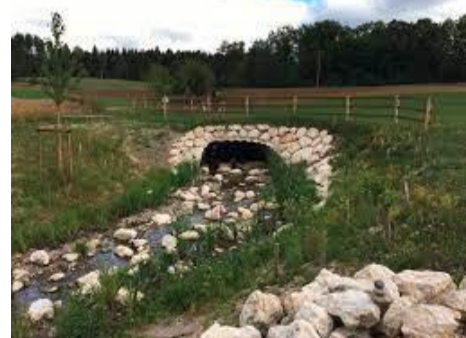
Exemple d'enrochement avant passage sous voirie
