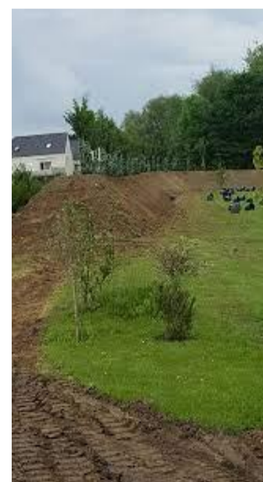
Exemple merlon en terre végétalisée
