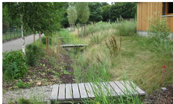
Exemple de noue pluviale : Sainte-Croix aux-Mines(68)
