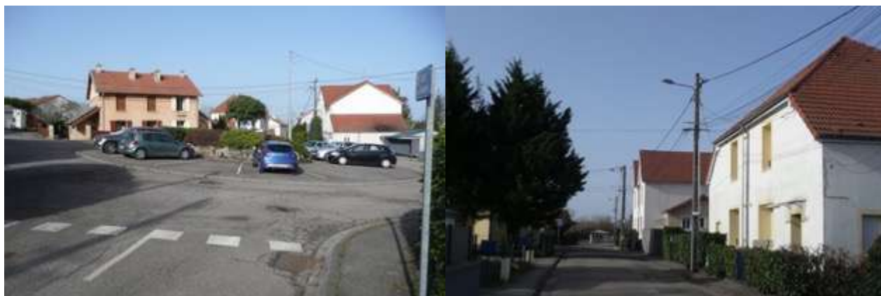
A gauche, la place centrale, qui fait la jonction avec la cité SNCF et les extensions au sud du centre historique et à droite un exemple de maisons jumelées caractéristiques.
