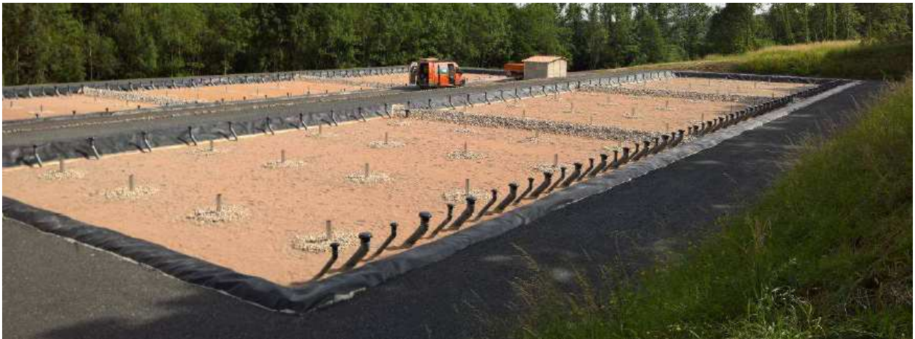
Figure 23 : Dimensionnement des ouvrages de traitement - exemple de réalisation FPRvv
