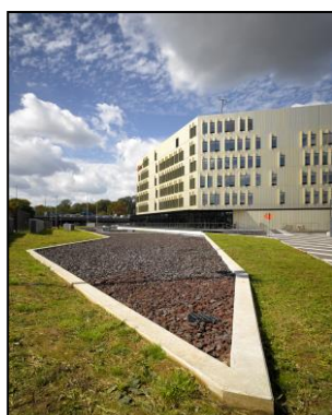
Massif d'infiltration à forte porosité
