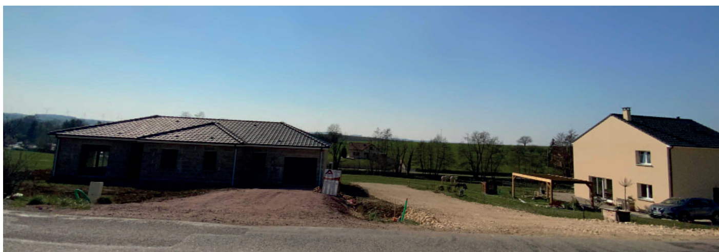
Constructions conemporaines en rupture avec les formes traditionnelles du bâti
