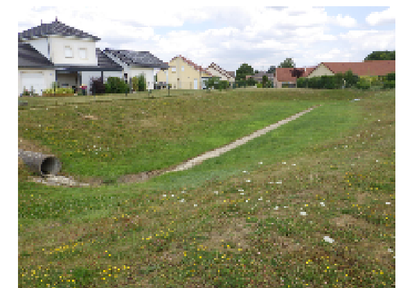
Photographie n°5 : Vue du bassin de rétention (rive gauche)
