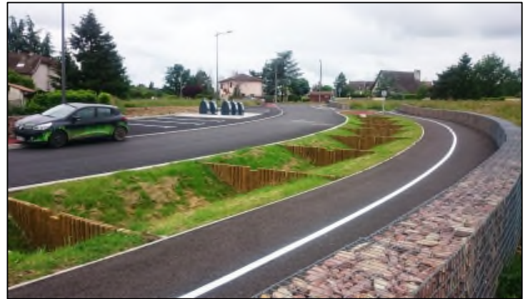
Noue avec cloison de stockage
