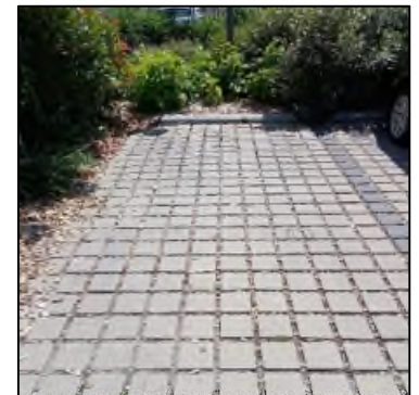
Place de parking en pavés drainants
