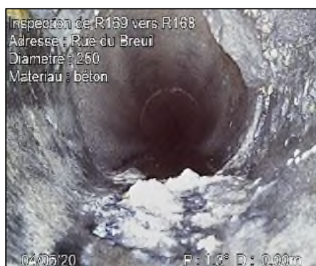
Dépôt de béton – Rue du Breuil
