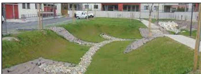
Exemple de bassin à ciel ouvert
