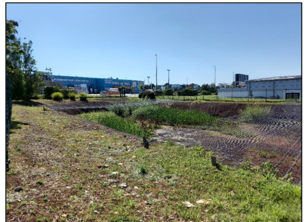
Bassin aérien de la zone d'activité Champ le Roi à Neufchâteau
