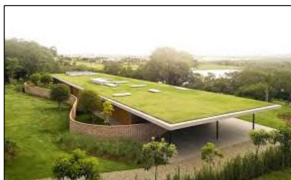
Exemple de toiture-terrasse végétalisée
