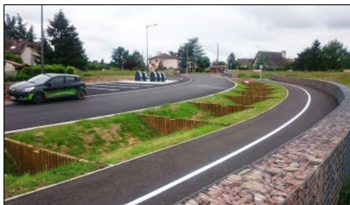
Noue avec cloison de stockage
