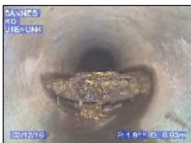
Dépôt de béton – Rte de Langres
