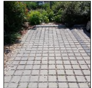
Place de parking en pavés drainants
