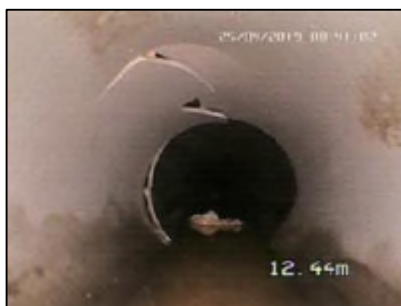
Fissures ouvertes
