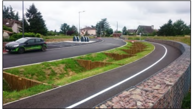
Noue avec cloison de stockage
