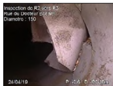
Raccordements défectueux
