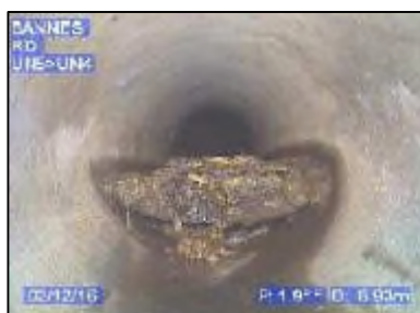
Dépôt de béton – Rte de Langres
