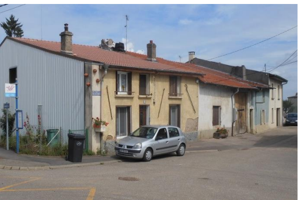
Photographie de la Rue de la Source aujourd'hui
