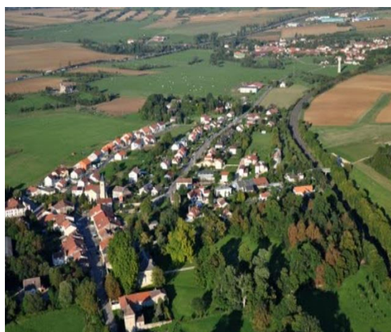
Vue aérienne en direction de Ville-en-Vermois
