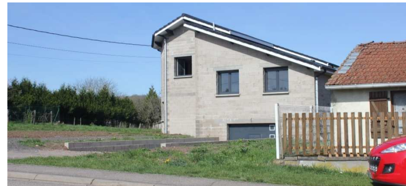
Logement en construction rue de Lunéville
