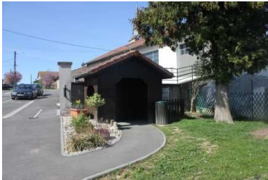
Abris bus rue de la Chapelle
