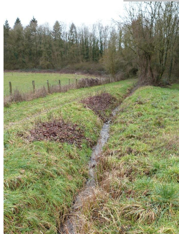
Photo 4 : vue du fossé du chemin à Le Rouau
