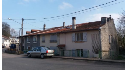
Rénovation des ouvertures du bâti du centre - bourg
