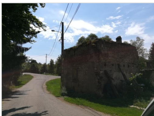
Figure 34 : Thiérouze, rue de Barbonfoing (CDA88)
