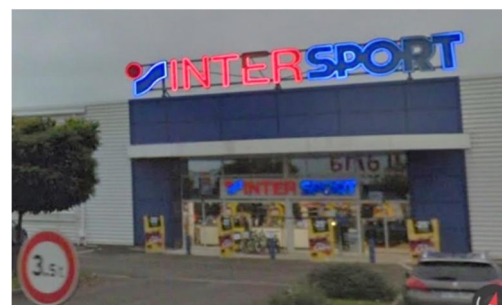
Enseigne en toiture Saint Dizier
