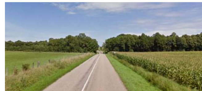
Accotement de la RD460, sur la commune de Fayl-Billot
