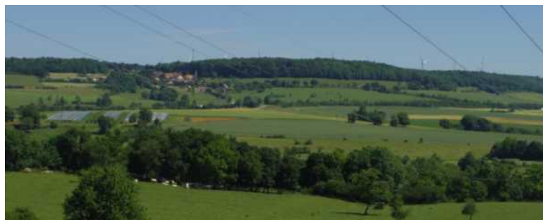
Présence d'un réseau électrique aérien bien visible. Parc éolien en arrière-plan.
