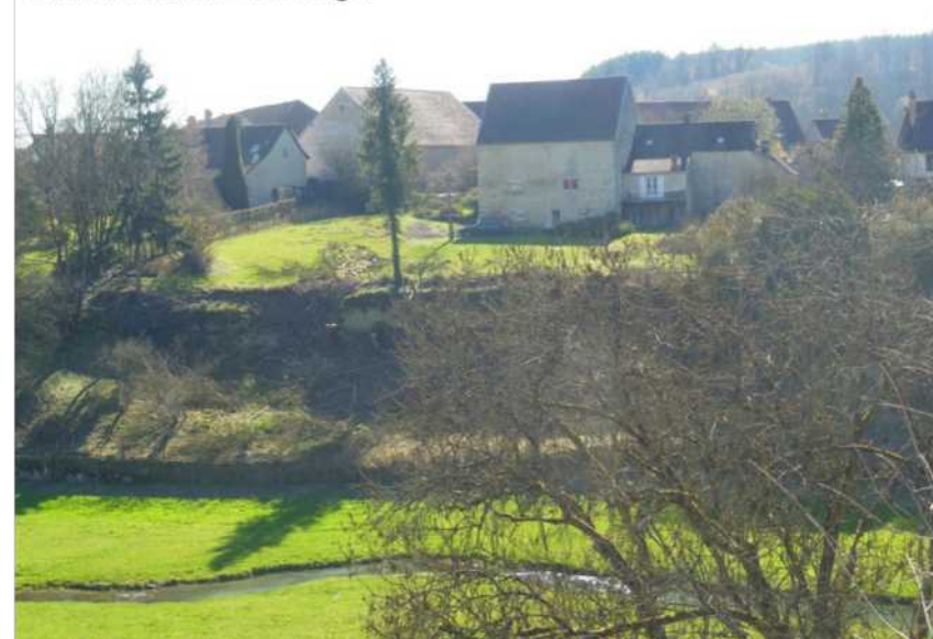
L'architecture en pierres calcaires, très présente dans l'ouest du territoire (Villars Santenoge)
