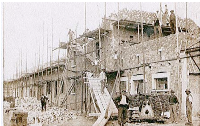
La reconstruction du village.
