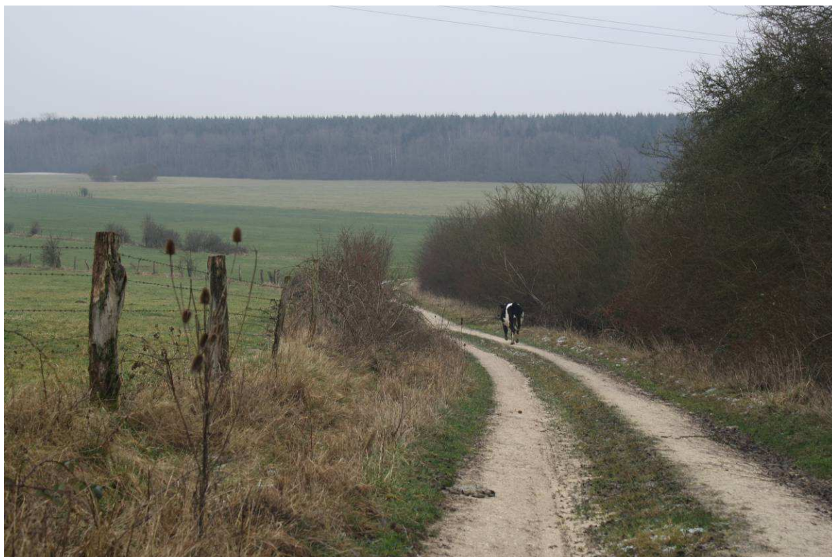
photo n°5 : chemin rural d'Azannes à Grémilly – chem in empierré en bon état
