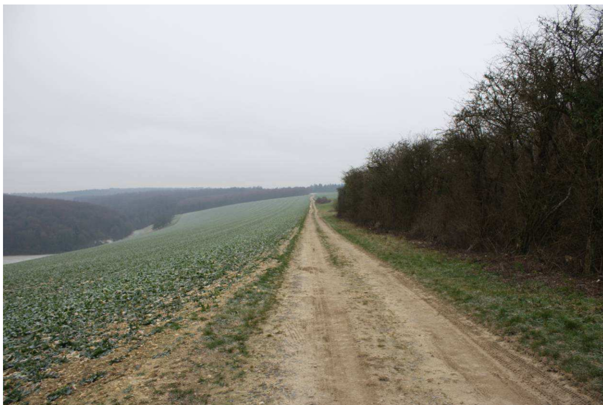
photo n°1 : chemin vicinal ordinaire n°2 – chemin em pierré en bon état
