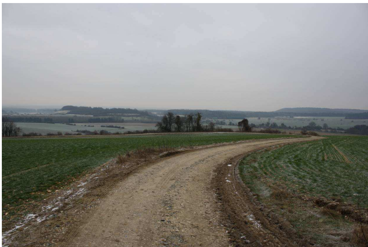
photo n°2 : chemin vicinal ordinaire n°2 – chemin em pierré en bon état
