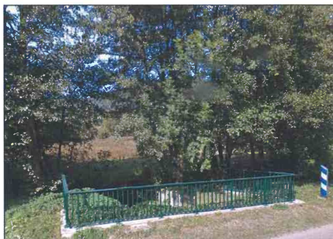
Figure 5 : Vue vers l'aval de l'ouvrage
