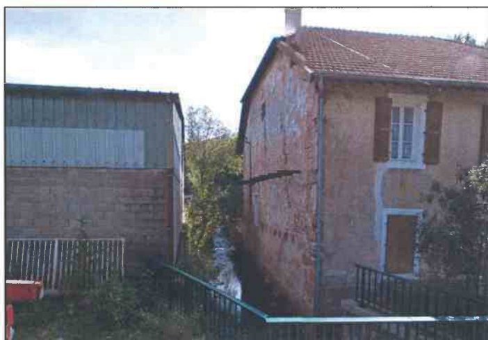
Figure 4 : Vue vers l'amont de l'ouvrage
