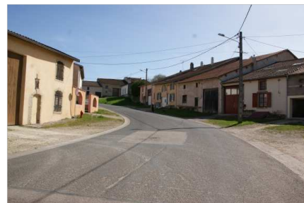
Habitations groupées avec d'anciennes fermes lorraines réhabilitées, rue du 79 ème Régiment d'Infanterie
