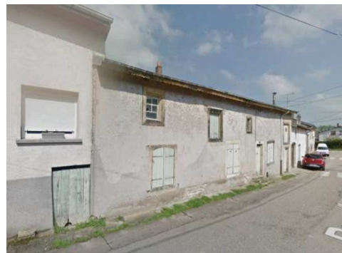
Rue de l'Eglise
