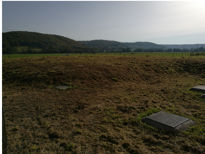
Vue d'ensemble sur l'ouvrage épuratoire (pré-traitement + terre d'infiltration)
