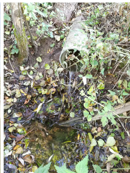
Exutoire des eaux traitées Ø200AC (Q=0.1 l/s)
