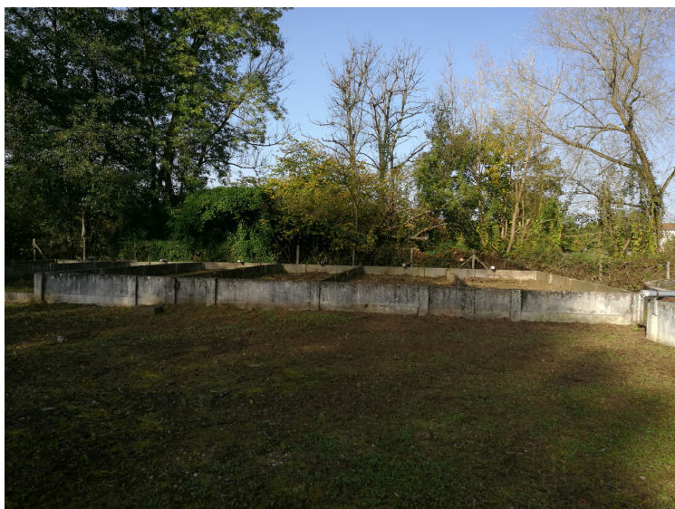
Lits de séchage des boues
