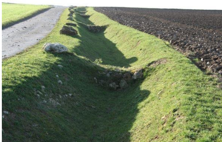
Photographie d'un fossé aménagé avec des redents.
