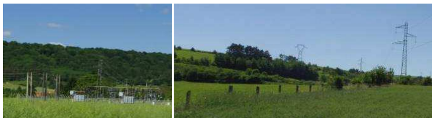
Entrée de Vesaignes-sous-Lafauche - Lignes électriques
