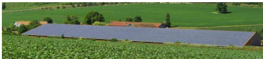
Hangar couvert de panneaux photovoltaïques
