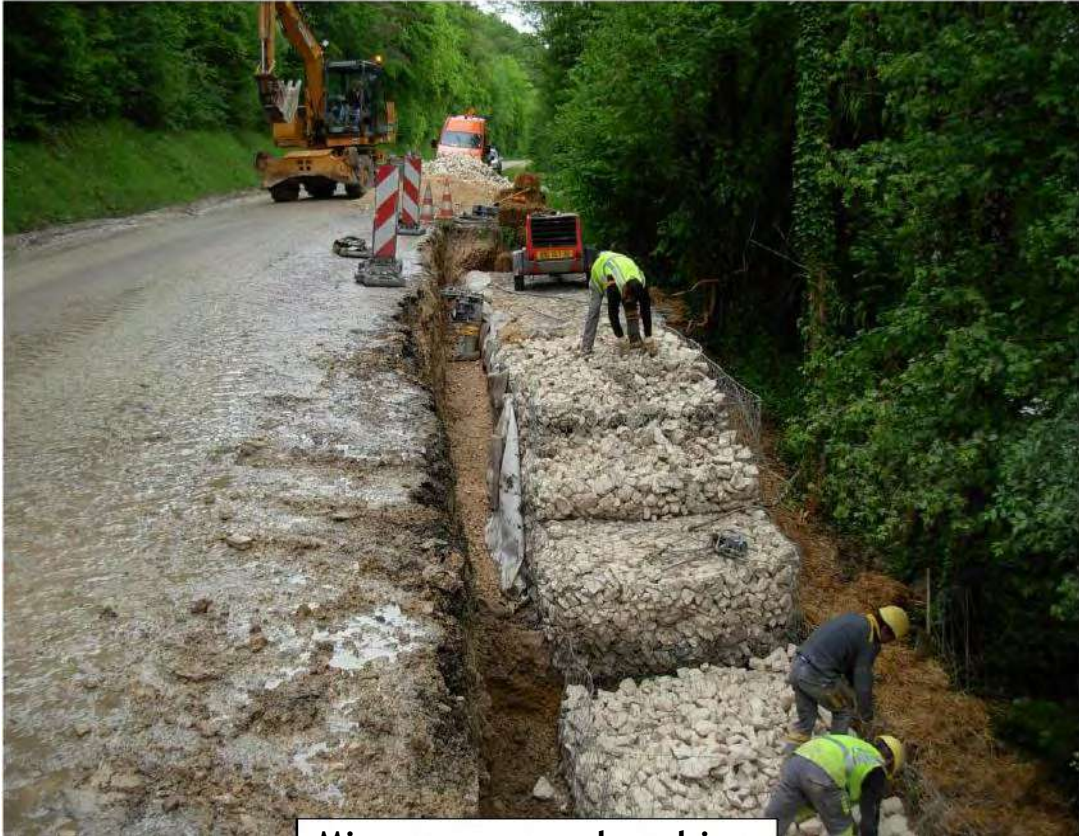
Mise en œuvre de gabions
