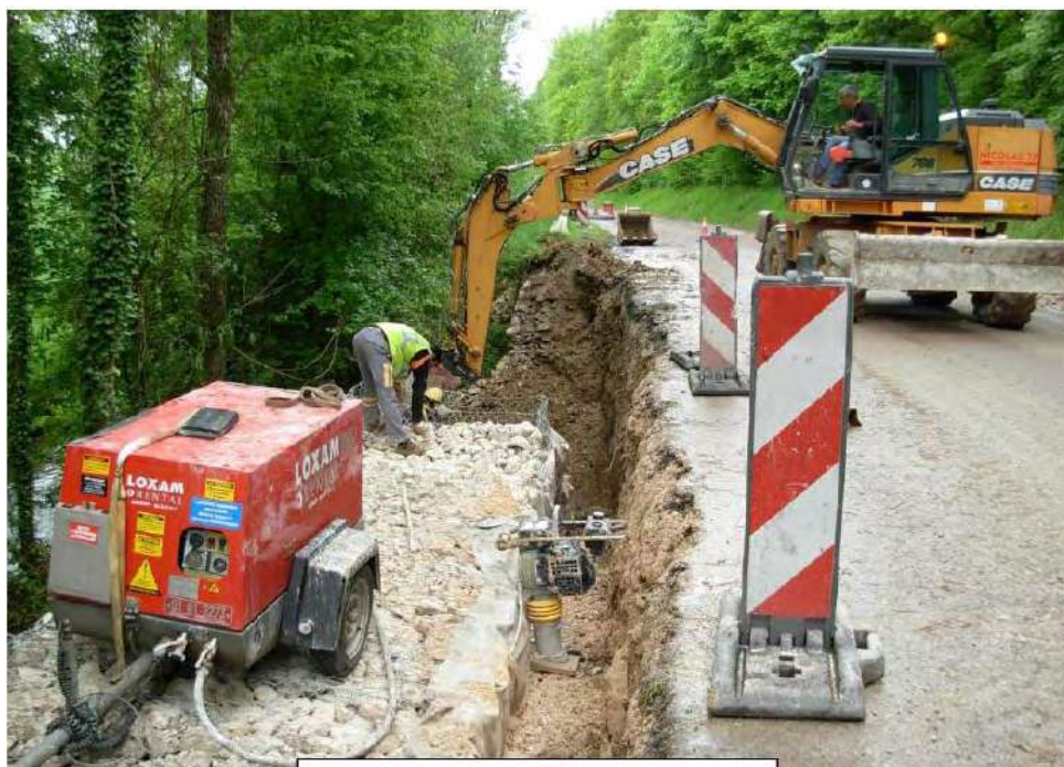
Mise en oeuvre des gabions
