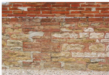
Soubassement en maçonnerie mixte, colorés de brique pilée
