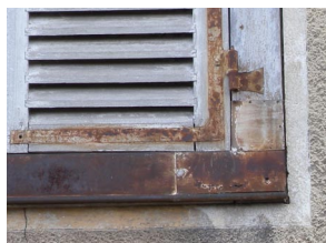
Pièce de zinc protégeant le cadre bois sur pan de bois enduit
