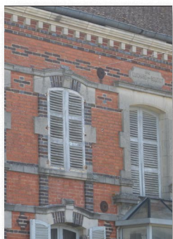
Trois matériaux seulement, utilisés dans une infinie variété d'assemblages : la brique de couleurs variées, le moellon calcaire, les blocs de craie taillés
