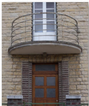
Garde-corps en profils d'acier du commerce, construction des années 1950, Brieenne-le-Château
