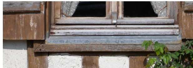
Pièce de zinc protégeant l'appui bois sur pan de bois apparent
