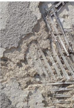
Enduit dégradé, les trois couches sur lattis sont visibles
