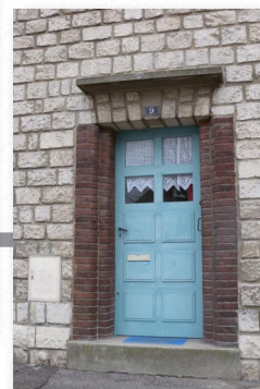
Façade des années 1950 : moellons de plus grandes dimensions posés en lits réguliers, briques spéciales avec un angle arrondi
