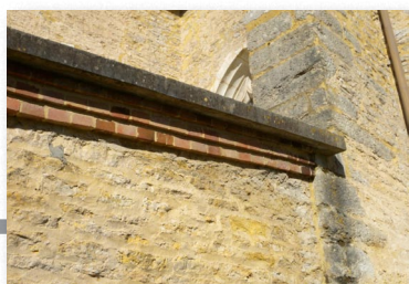
Pierre calcaire avec joints beurrés, bandeau de brique saillant, Chauffour-les-Bailly
