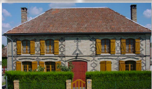
Trois matériaux seulement, utilisés dans une infinie variété d'assemblages : la brique de couleurs variées, le moellon calcaire, les blocs de craie taillés
