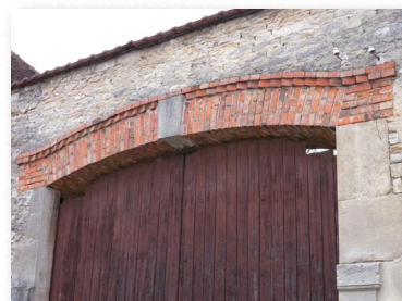
Linteau de brique avec clé et piédroit en pierre de taille, maçonnerie de moellons calcaire, Bossancourt
