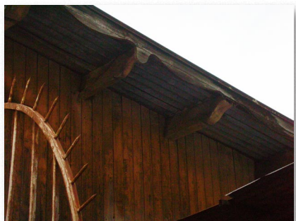
Bardage de châtaignier, frise de bois en rive de toiture, Vendeuvre-sur-Barse
