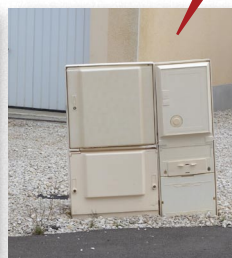
Coffrets posés sans soin : ni alignement ni intégration au bâti
