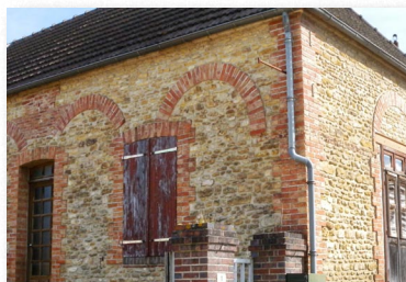
Moellons calcaires à jointoiment en creux, chaînages et encadrements en brique saillants indiquant qu'un enduit était probablement prévu, Briel-sur-Barse
