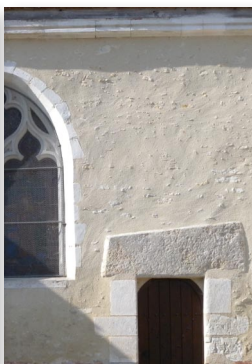
Enduit à la craie mis en oeuvre à pierre vue, Villemoyenne
