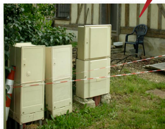
Coffrets posés sans soin : ni alignement ni intégration au bâti
