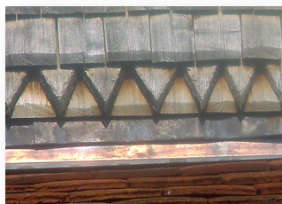
Essentes écailles et rectangles, couverture cuivre, Chauffour-les-Bailly
