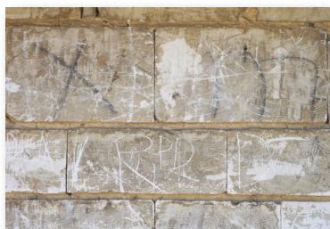
Appareillage de craie : assises régulières, joints verticaux sans mortier, Molins-sur-Aube
