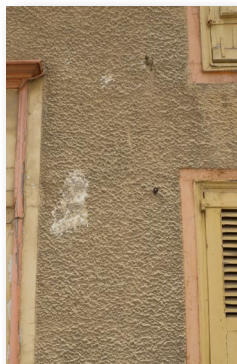
Enduit tyrolien, encadrements de baies lissés colorés
