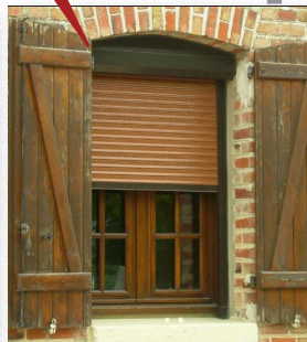
Volet roulant avec coffre apparent et sans respect pour le linteau courbe de la brique
