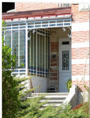
Véranda en acier et vitraux colorés
