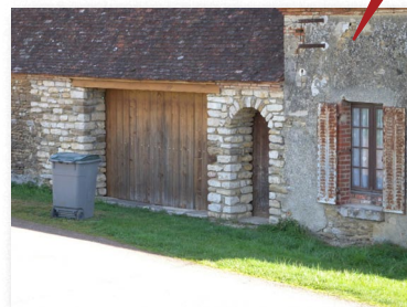
Maçonnerie de moellons de grosse taille avec joints en creux au mortier de ciment, linteau de porte incongru en voûte plein cintre, ce travail récent ne correspond pas aux techniques en usage dans le Parc
