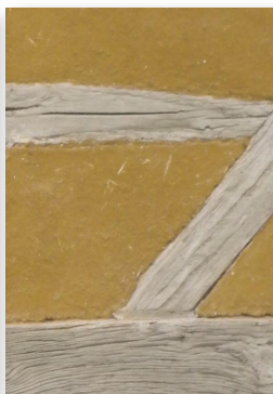
Enduit sur torchis ou mortier de chanvre teinté avec pigment minéral, Courteranges
