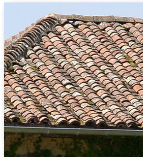
Tuiles à la "romaine", faîtage en tuiles canal emboîtées
