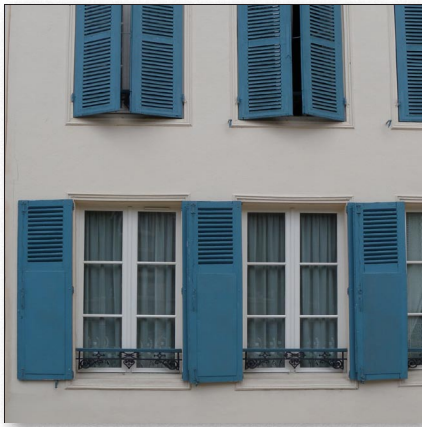
Percements caractéristiques d'une habitation en ville : fenêtres en bois peint avec petits bois, volets en bois peint, persiennés à l'étage et semi-persiennés au niveau de la rue, garde-corps fonte avec appui bois peint, Brienne-le-Château
