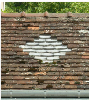
Inclusion de tuiles de verre écaillée dans un pan de tuiles plates pour apport de lumière
