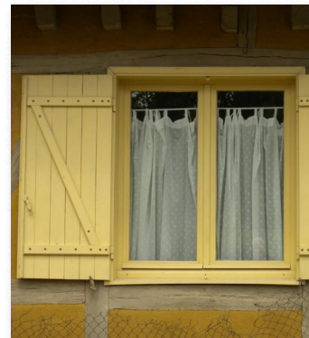
Fenêtre et volets bois dans le pan de bois, cadre de baie en bois, Courteranges
