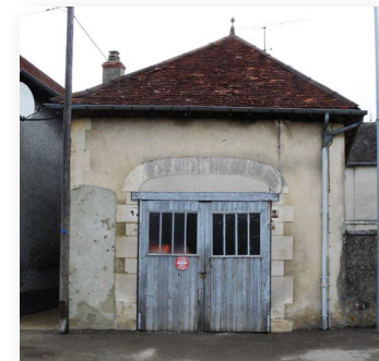
De grandes portes de bois inscrites sous un arc de décharge en pierre incorporent des parties vitrées, Vendevre-sur-Barse
