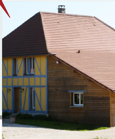
Attention aux proportions des fenêtres créées dans une extension : elle doivent être soit verticales pour s'accorder à la construction traditionnelle, soit franchement horizontales pour affirmer une modernité en contraste avec la tradition
