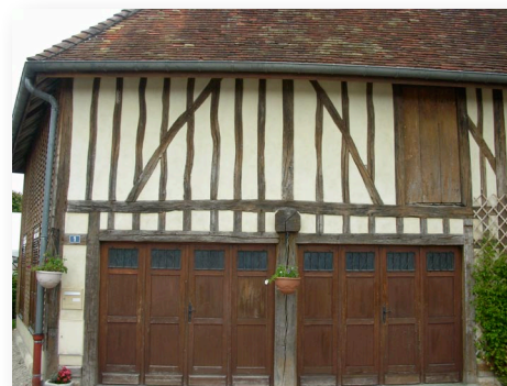
Intégration de portes de garage dans une façade de pan de bois, Courteranges
