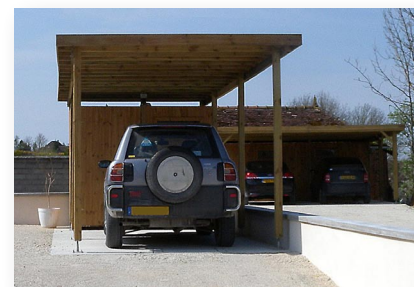
Abri de voiture ou carport, Laubressel
