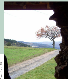
Création d'une baie (en cours de travaux) : un paysage révéélé (hors PNR)
