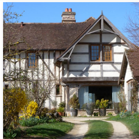
Maison restaurée, Montreuil-sur-Barse
