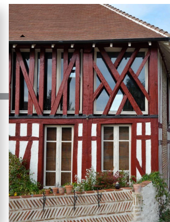
Fenêtres placées derrière le pan de bois
