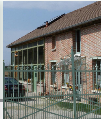
Une grande pièce éclairée par une verrière installée dans le volume de la construction et en continuité de la façade, Mesnil-Sellières
