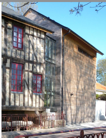
Une extension sans pastiche : le volume contemporain en bardage bois reprend la volumétrie de la maison en pan de bois et non pas les percements. Une transition franche est effectuée grâce à une grande verrière de couleur neutre placée en retrait des façades, Larrivour / Lusigny-sur-Barse
