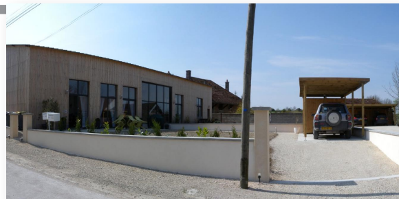
Transformation d'un hangar en deux habitations contemporaines, Laubressel
