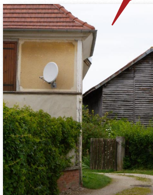
Antenne posée sur un panneau d'enduit ancien avec encadrement décoratif
