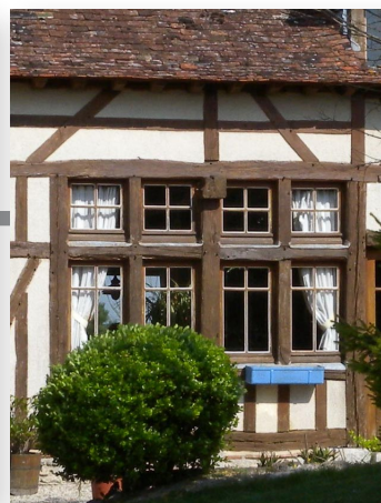
Ensembles de fenêtres inscrits dans la charpente du pan de bois
