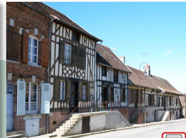
Tuile plate, toitures à deux pans, façades en pans de bois, Montiéramey
