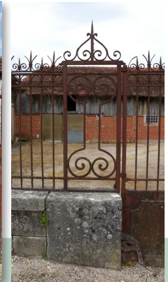
Grille avec poteau de portail, Rouilly-Sacey
