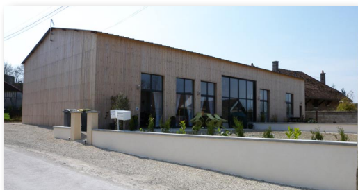
Bardage bois sur un hangar réaménagé en deux habitations, Laubressel
