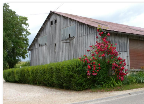
Haie taillée, rosiers, iris suffisent à rendre accueillant un hangar en état médiocre, Bouy-Luxembourg
