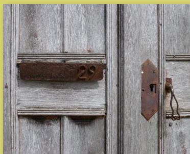
Boîte aux lettres avec numéro en relief, entrée de clé, poignée en fer forgé, Vauchonvilliers
