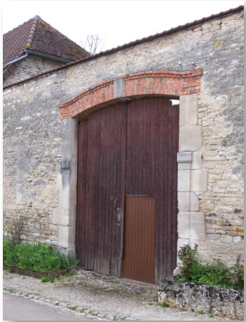
Porte charretière, probablement réhaussée comme en témoignent les pierres de tableau, Bossancourt
