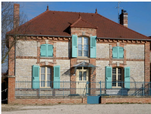
Volets bleu-vert, fenêtres et portes jaune clair dans façade pierre à motifs de brique, Montreuil-sur-Barse
