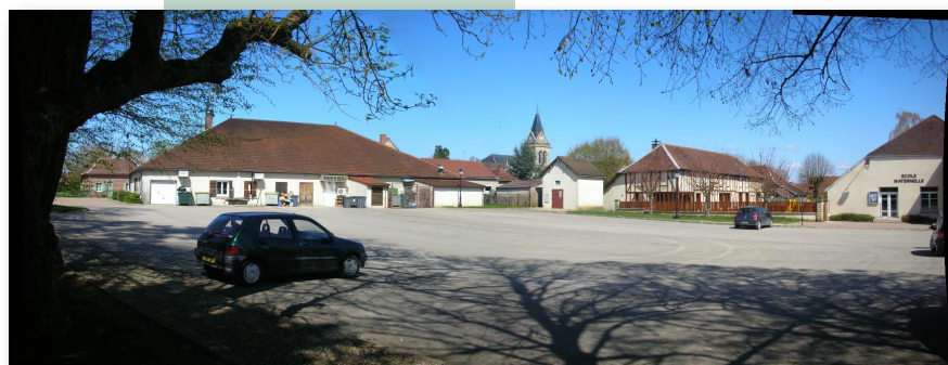
Un grand parking sur lequel donnent directement une école aussi bien que l'arrière des commerces avec les livraisons et les poubelles : un vaste espace public dont les limites sont imprécises et la qualité très inégale, Lusigny-sur-Barse
