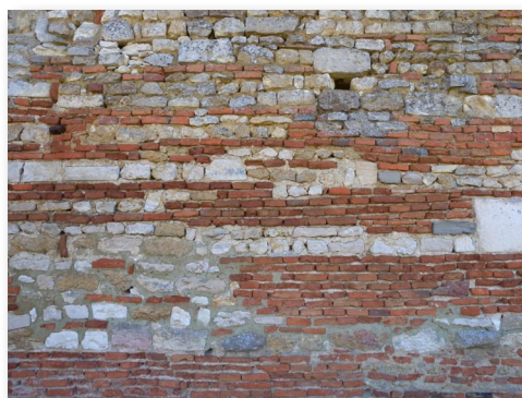
Maçonnerie mixte brique, pierre calcaire, craie, Montiéramey
