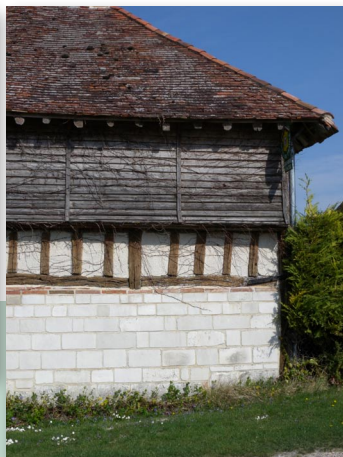
Craie, brique, pan de bois apparent à remplissage maçonné enduit, pan de bois masqué par des clins, tuile plate, Laubressel
