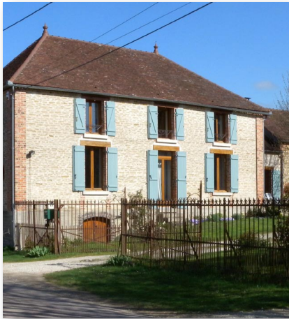
Volets bleus dans une façade de pierre avec chaînages brique, linteaux et fenêtres bois, Montreuil-sur-Barse
