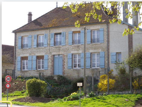
Maison de maître en pierre du Barrois, Briel-sur-Barse
