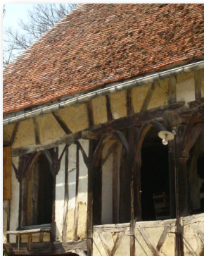
Baies ouvertes dans un pan de bois, Lesmont
