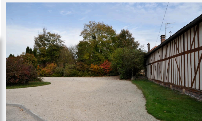
Parking public aménagé "en douceur" : superficie recoupée, sol perméable, arbustes, surfaces enherbées, Onjon
