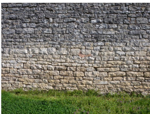
Maçonnerie de pierre calcaire, La Villeneuve-au-Chêne
