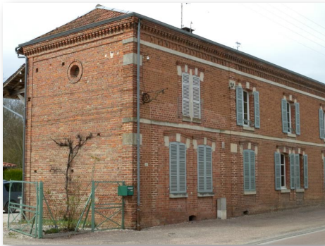
Volets bleu-gris, fenêtres blanc cassé dans une façade en briques soulignées de pierre calcaire, Dienville
