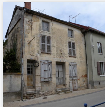
Deux habitations jumelées datant du XIXème siècle, à restaurer, Vendevre-sur-Barse
