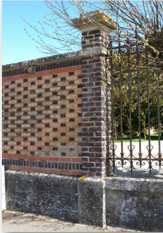
Clôture mixte très ouvragée combinant grille en serrurerie et mur de brique tricolore sur soubassement de pierre de taille, Lusigny-sur-Barse
