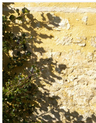
Maçonnerie de calcaire avec enduit à pierre vue, chaux + sable ocre, Chauffour-lès-Bailly
