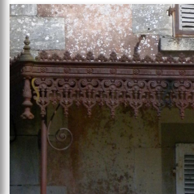
Marquise en fonte avec lambrequins ouvragés, Molins-sur-Aube
