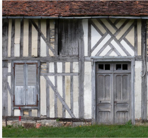
Porte d'entrée à panneaux double vantail et petite imposte vitrée, volets semi-persiennés, porte d'accès au comble, Mesnil-Sellières
