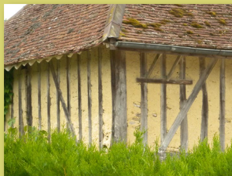
Pan de bois avec hourdis en torchis, Courteranges
