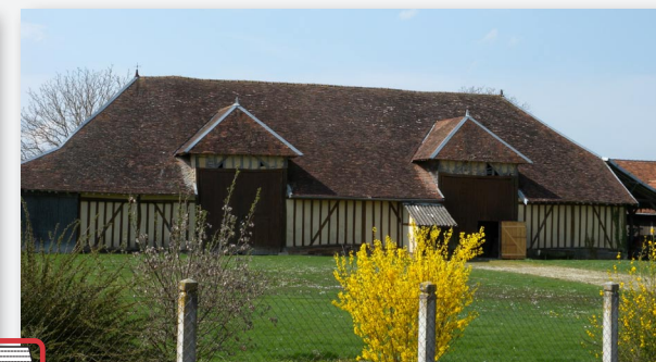
Grange à deux porches, Mesnil-Sellières
