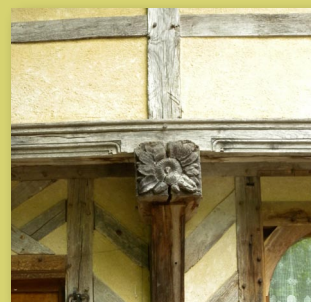
Pan de bois sculpté, hourdis restauré en torchis enduit, Courteranges
