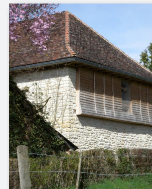
Pierre et tuile plate, association de moellons calcaire et de bardage bois, La Villeneuve-au-Chêne
