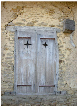
Linéaire et cadre bois dans une maçonnerie de pierre, Villemoyenne
