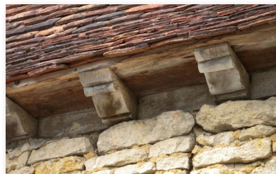
Consoles de bois sculptées supportant le débord de toiture, Vendevre-sur-Barse
