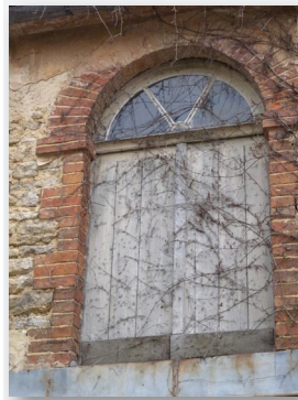
Imposte vitrée en quart de cercle, Vendeuvre-sur-Barse
