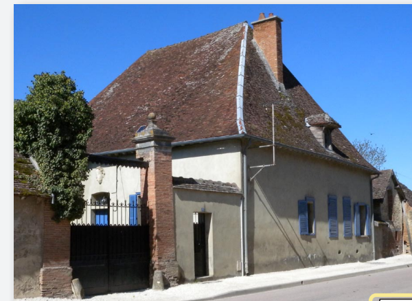
Tuile plate, toiture à quatre pans, façades en maçonnerie, Montiéramey
