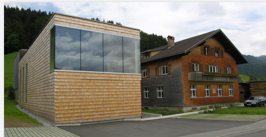
Deux maisons en tavaillons côte à côte, l'une récente, l'autre datant d'une centaine d'années; les tavaillons modernes prendront sous quelques mois la teinte brun chaud des tavaillons patinés de la maison ancienne, Vorarlberg (Autriche)
