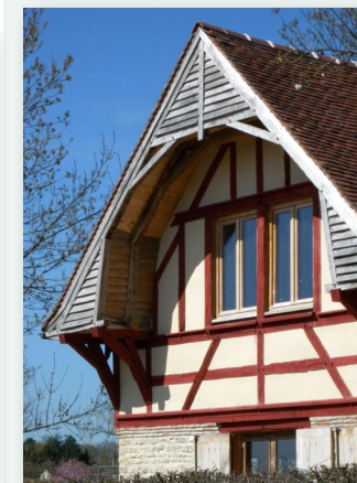
Bardage de planches brutes pan de bois rouge, enduit de ton clair, fenêtres bois lasuré, pierre, Lusigny-sur-Barse
