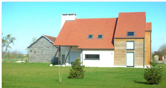
Bardage bois, Montreuil-sur-Barse
