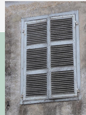
Volets persiennés à pentures en équerre, façade enduite avec encadrements de fenêtres en bois (pan de bois), Brienne-le-Château
