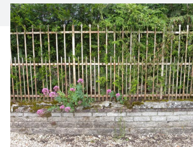
Grille en acier peinte, muret de pierre et de brique, haie vive, Géraudot
