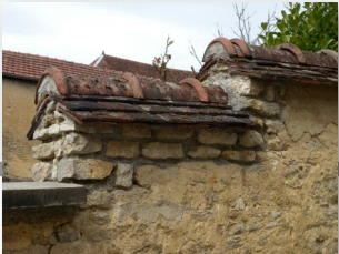
Couronnement en tuiles plates et faîtières d'un mur de clôture en moellons calcaires, Vendevre-sur-Barse
