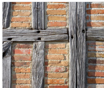
Pan de bois à hourdis de brique, Montreuil-sur-Barse
