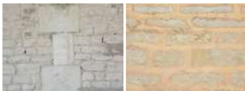
Mise en œuvre de la craie à Mergey
